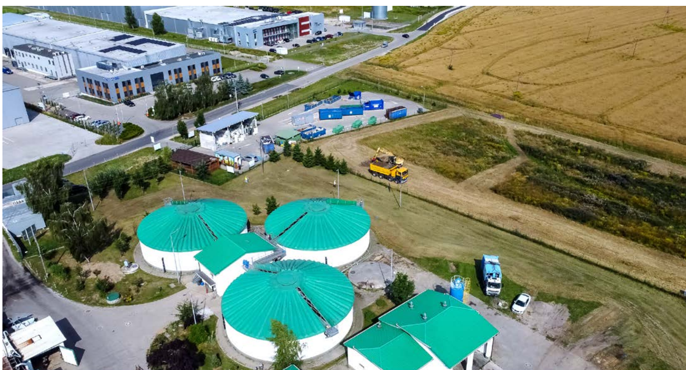
Rozbudowa oczyszczalni ścieków PUK Sp. z o.o. w Bytkowie
