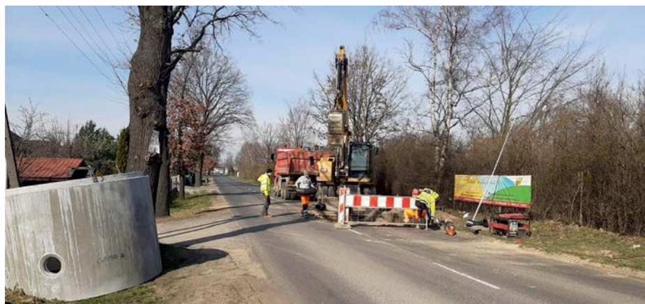
Budowa sieci kanalizacji os. Europejskie Kiekrz ul. Błękitna – marzec 2020
