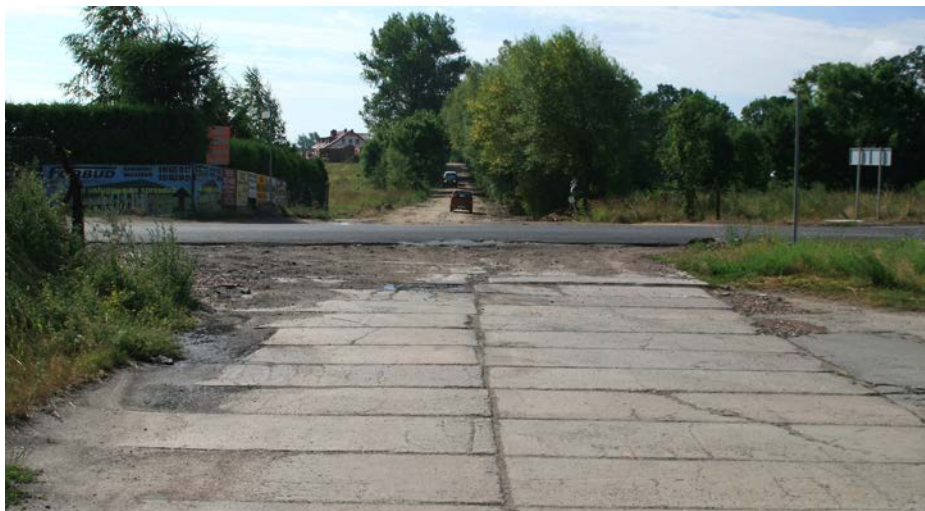
Zdjęcie 1. Widok z ul. Trakt Napoleoński w kierunku drogi S11. Obecnie w tym miejscu jest rondo, na którym krzyżują się ul. Szkolna i ul. Trakt Napoleoński.
