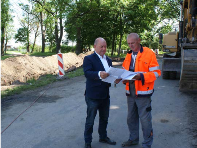
BUDOWA KANALIZACJI ROSTWOROWO-ŻYDOWO
