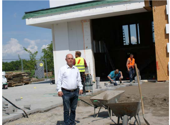
BUDOWA REMIZY STRAŻACKIEJ W PRZYBRODZIE
