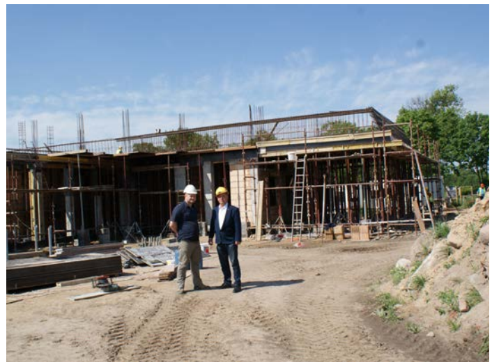
BUDOWA ZAJEZDNI AUTOBUSOWEJ W ROSTWOROWIE
