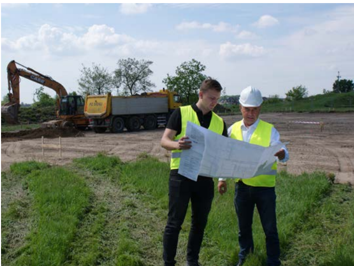
BUDOWA SZKOŁY PODSTAWOWEJ W CEREKWICY
