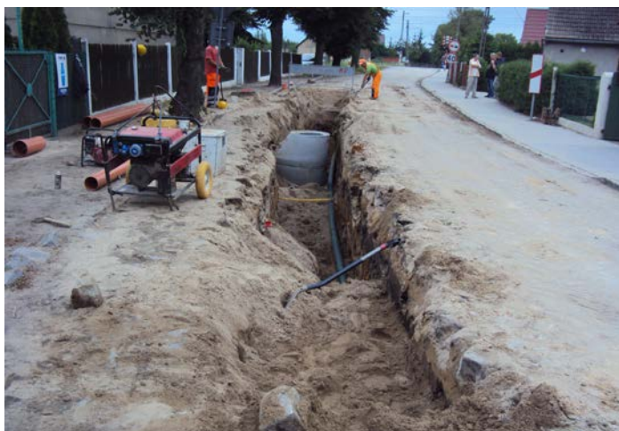
Budowa sieci kanalizacyjnej w Krzyszkowie, rok 2016
