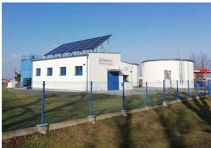
Stacja Uzdatniania Wody, Rokietnica, ul. Szkolna, rok 2016
