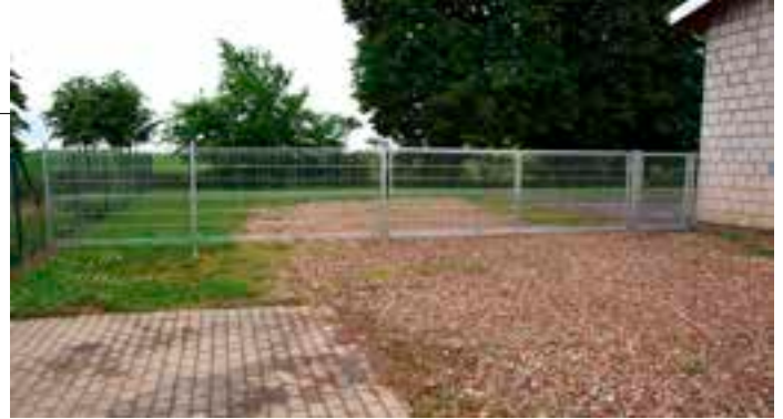
Ogrodzenie wraz z monitoringiem świetlicy wiejskiej w Żydowie – zadanie o wartości 8 802, 89 zł wykonane w ramach funduszu sołeckiego
