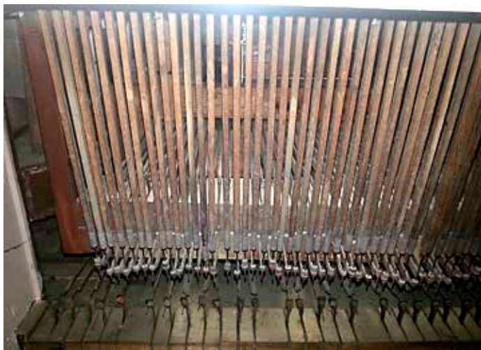
Zniszczone elementy traktury
