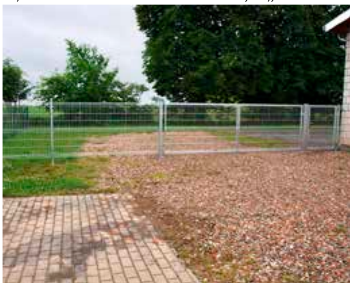
📍 Ogródzenie przy świetlicy wiejskiej w Żydowie
