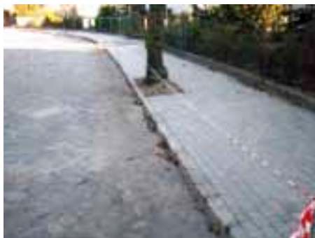
Krzyszczkowo – remont chodnika przy ul. Głównej
