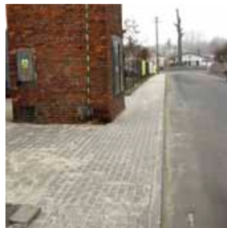
Rokietnica – remont chodnika przy ul. Rolnej
