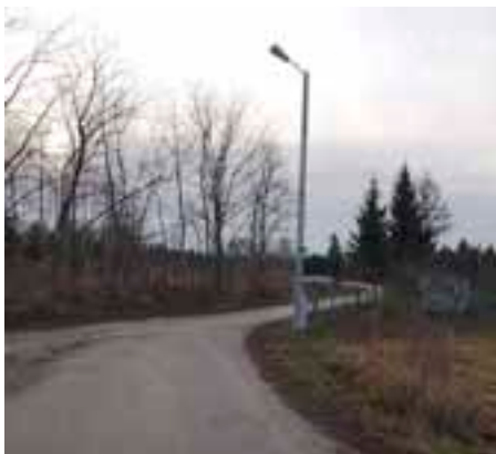
Starzyny-Rogierówko wykonanie oświetlenia na ul. Kościuszki w Rogierówku
