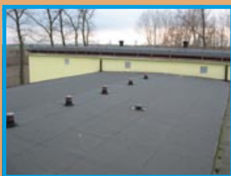
Remont dachu w Zespole Szkół w Rokietnicy
