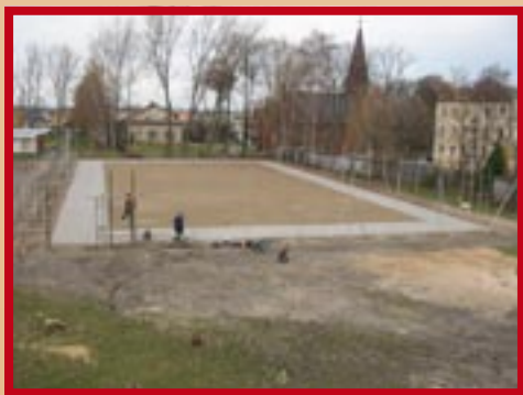
Budowa boiska przy Zespole Szkół w Rokietnicy
