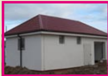
Budowa kanalizacji sanitarnej i przepompowni w Mrowinie
