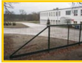
budowa ogrodzenia Gimnazjum w Napachaniu
