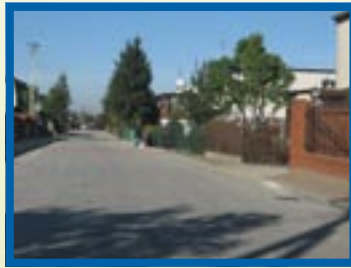
nawierzchnia z kostki betonowej Rokietnica ul. Kręta
