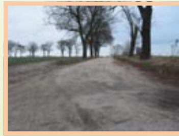
rekultywacja drogi stanowiącej dojazd do gruntów rolnych Napa- chanie-Dalekie
