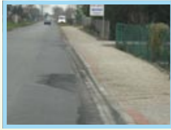
budowa chodnika Kiekrz ul. Kierska
