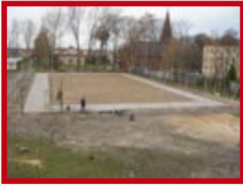
boisko wielofunkcyjne ze sztuczną nawierzchnią przy Zespole Szkół w Rokietnicy
